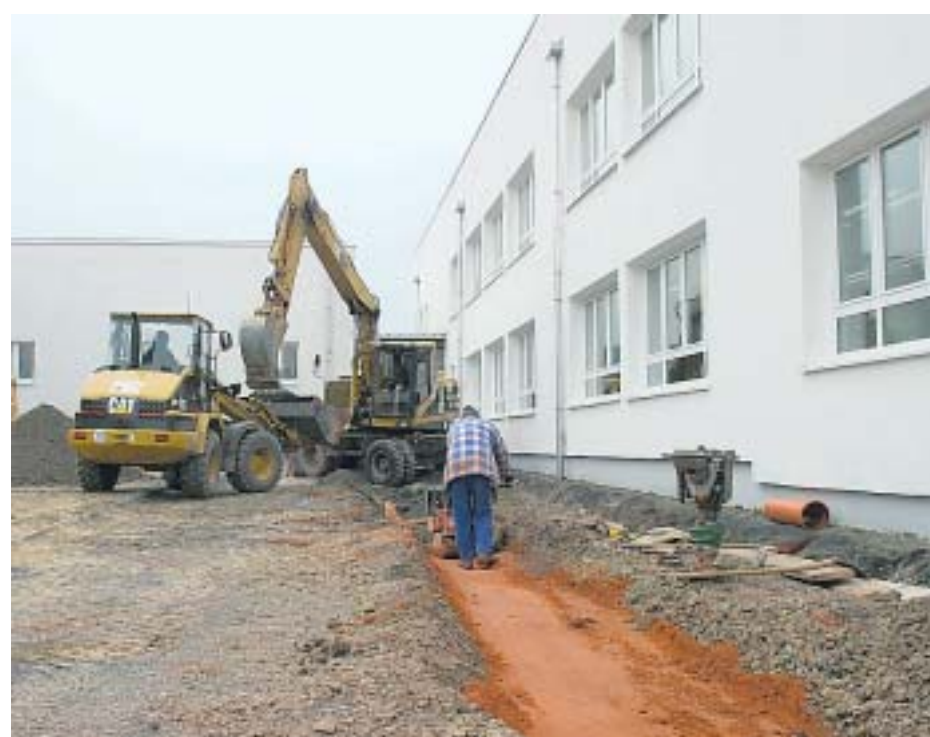
Die Arbeiten hinter Gebäude A an der FH sind in vollem Gange. Foto: tof
